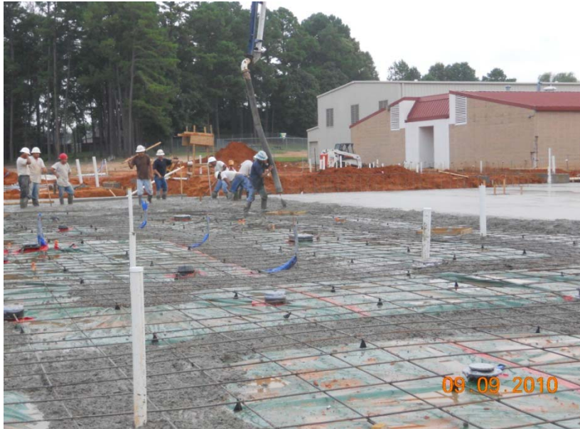
Photo #1 Cafeteria Slab Pour
